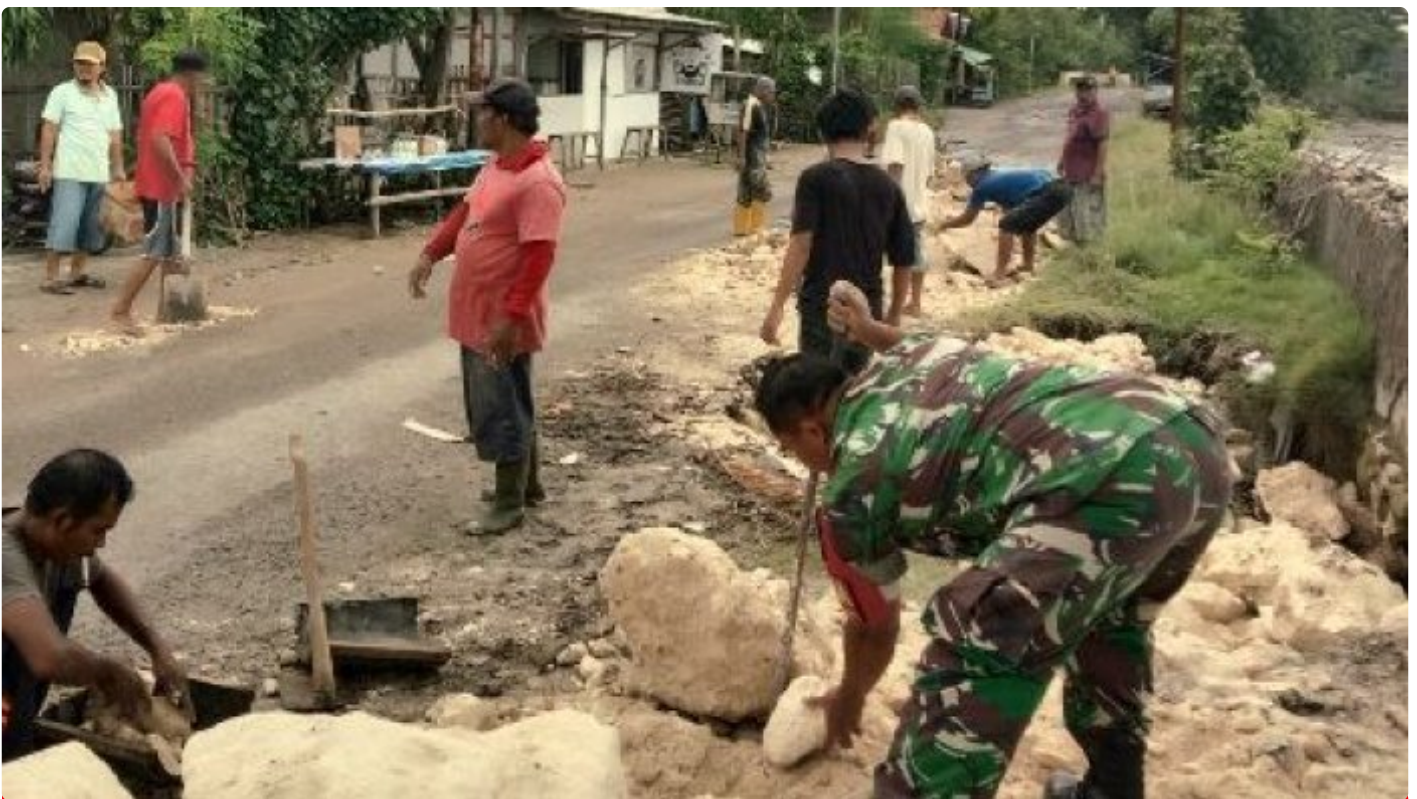
Babinsa Koramil 0829-12/Modung bersama-sama warga memperbaiki jalan yang rusak
